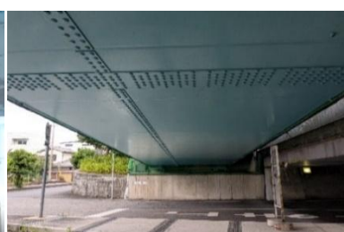
塗膜変状なし
