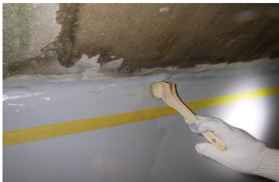
図 24 橋脚耐震補強鋼材とコンクリートと境界部の止水
