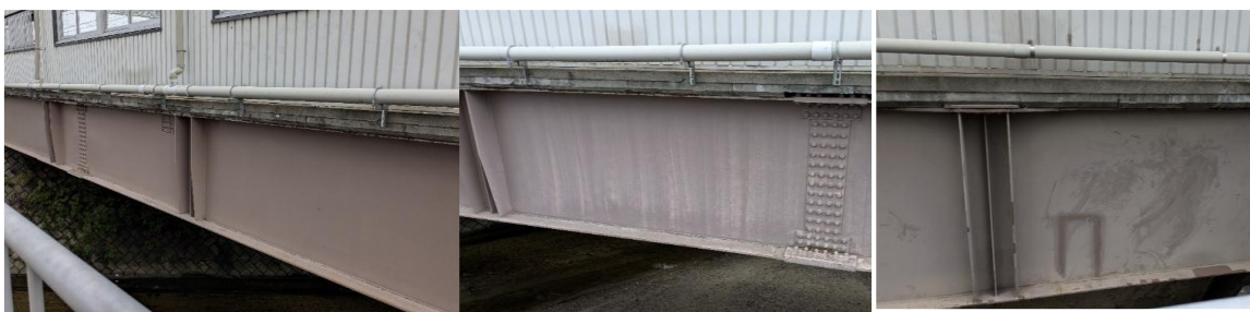
図 16 無溶剤無機形塗料仕上げ 図 17 シリコン変性エポキシ仕上げ 図 18 ポリウレタン仕上げ
