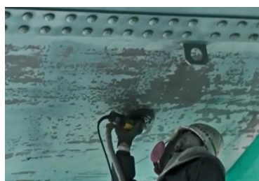
動力工具処理
