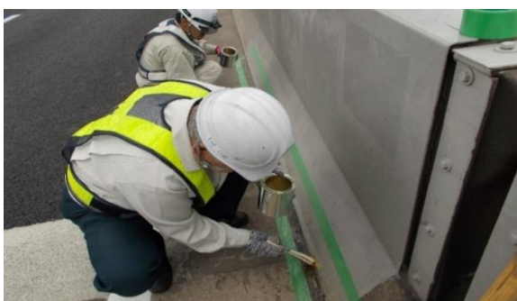
図 26 高欄と路面の境界部の止水
