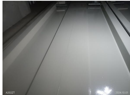
無機有機ハイブリッド 塗料シンク補修塗り + 無機有機ハイブリッド 塗料 1 回塗り 図 23 施工完了
