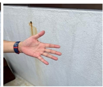
図 13 うるま市民家 29 年経過 図 14 白亜化の確認 図 15 白亜化なし
