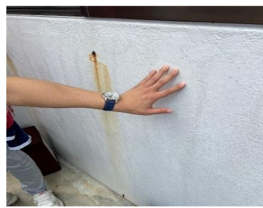
図 13 うるま市民家 29 年経過 図 14 白亜化の確認 図 15 白亜化なし
