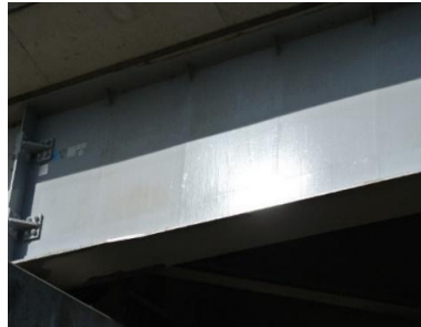
図 10 六間川橋試験塗装桁全景 図 11 ウェブ 太陽光線反射 図 12 下フランジ 下面同反射
