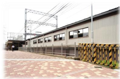
図 16 駅ホーム柵全景
