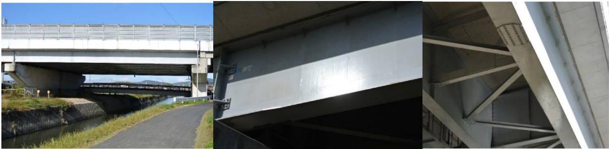
図 10 六間川橋試験塗装桁全景 図 11 ウェブ 太陽光線反射 図 12 下フランジ 下面同反射
