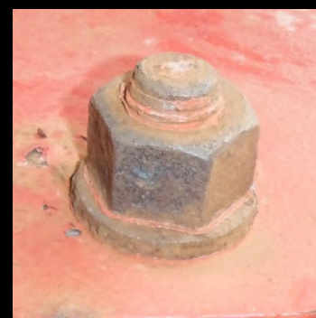
ケレン後の状況
