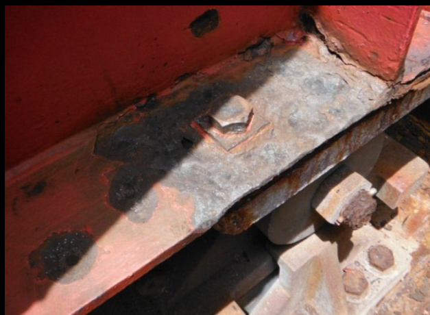
ケレン後の状況
