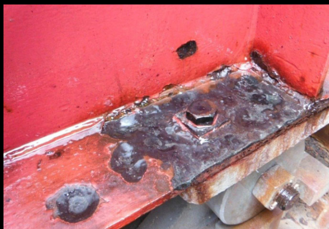
FeプロトFASをスプレー (ケレンから塗布完了まで15分程度)
