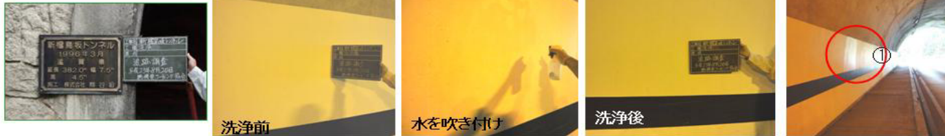
洗浄調査：簡単に水拭きで汚れが落ちます。 水拭きした箇所は 光沢が戻っているのが判ります。
